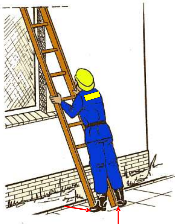
Sichern des Leiterfußes durch den zweiten Helfer
